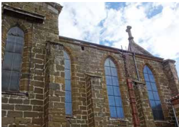
État initial de la façade ouest
