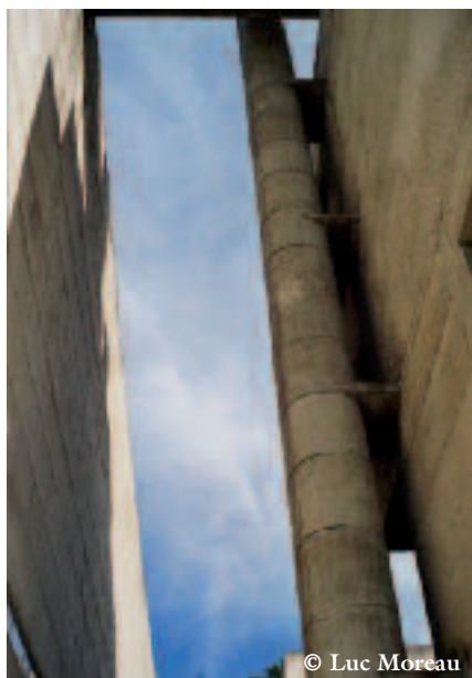
Le corps du bâtiment, et la cheminée, ne sont pas collés contre l'église. Un espace laisse entrer la lumière dans la cour intérieure.
