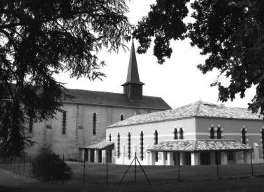
HÔTELLERIE : VUE EXTÉRIEURE
