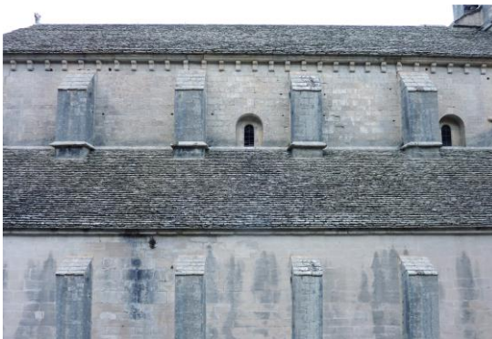
Collatéral après l'édification des contreforts
