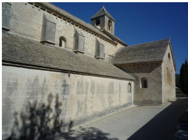
Collatéral avant l'édification des contreforts
