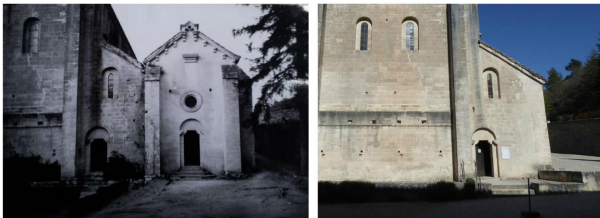
Fig.2 - Façade Sud de l'abbatiale. Avant sa destruction, la chapelle des Dames contrebutait le bas-côté Est
