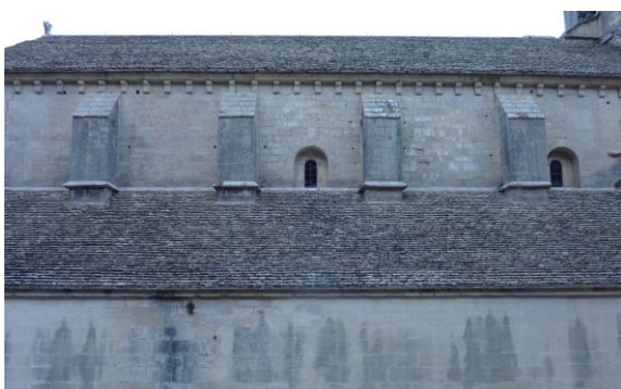
Collatéral avant l'édification des contreforts
