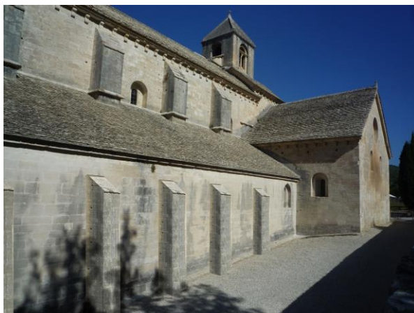
Collatéral après l'édification des contreforts
